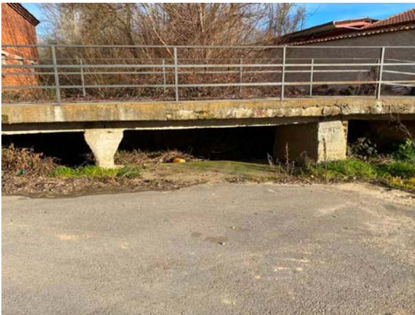
7.-Puente sobre el arroyo Valcarcel
