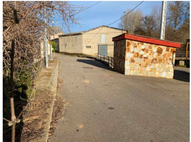
2.-Captación de agua actual.
